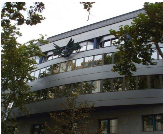
Az MNB számítástechnikai épülete.
